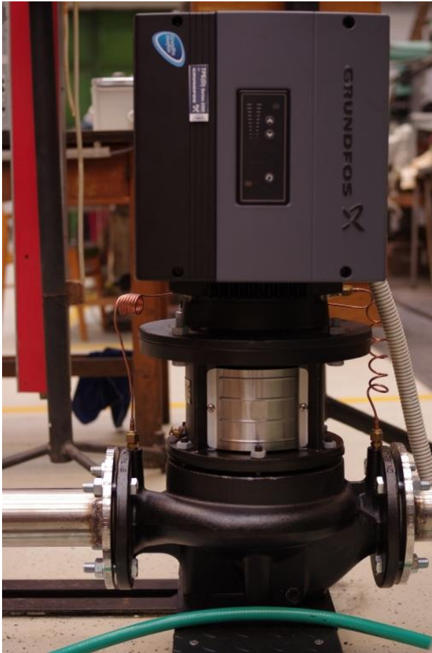
3. ábra. bal oldal: örvényszivattyú-villanymotor-frekvenciaváltó gépcsoport, jobb oldal: csigaház légtelenítő szelepe
