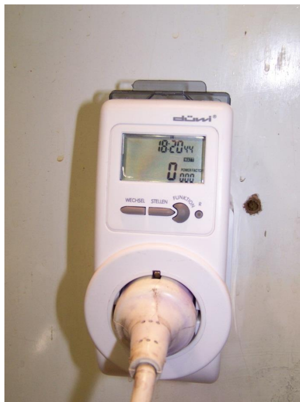
A generátor hasznos teljesítményének mérésére beépített villamos műszer
