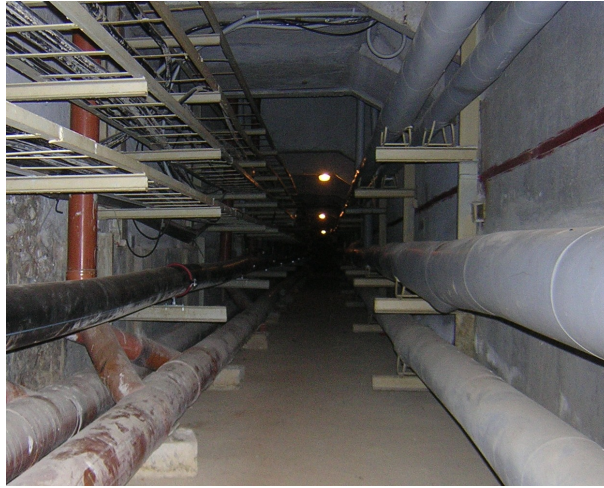
3.2. ábra. Közműalagút Pécsen (Forrás: www.tettyeforrashaz.hu )
