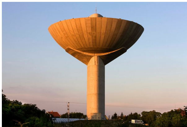
3.4. ábra. A Budafoki víztorny (Forrás: ittlakunk.hu )
