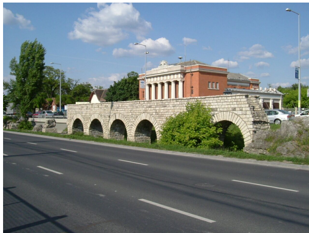
2.1. ábra. Aquincumi vízvezeték rekonstruált darabja (Forrás: Wikipédia)
